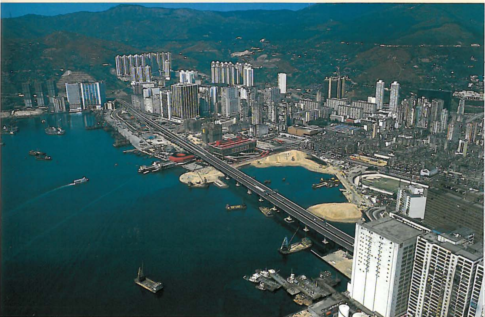
現代建設處處可見：（左上）灣仔的高樓大廈與中區連在一起，前景可見直升機場和香港演藝學院。（右上）東區走廊環繞的太古城，是中層入息階級的私人樓宇建設，包括購物中心和康樂設施。（右下）荃灣興建的繞道天橋。荃灣是新界一個有七十萬人口的繁盛的第一代新市鎮，發展成為九龍市區的工業衛星城市。（左下）沙田新市鎮是另一個有五十萬人口的第一代衛星城市，亦是沙田第一城的所在地。
