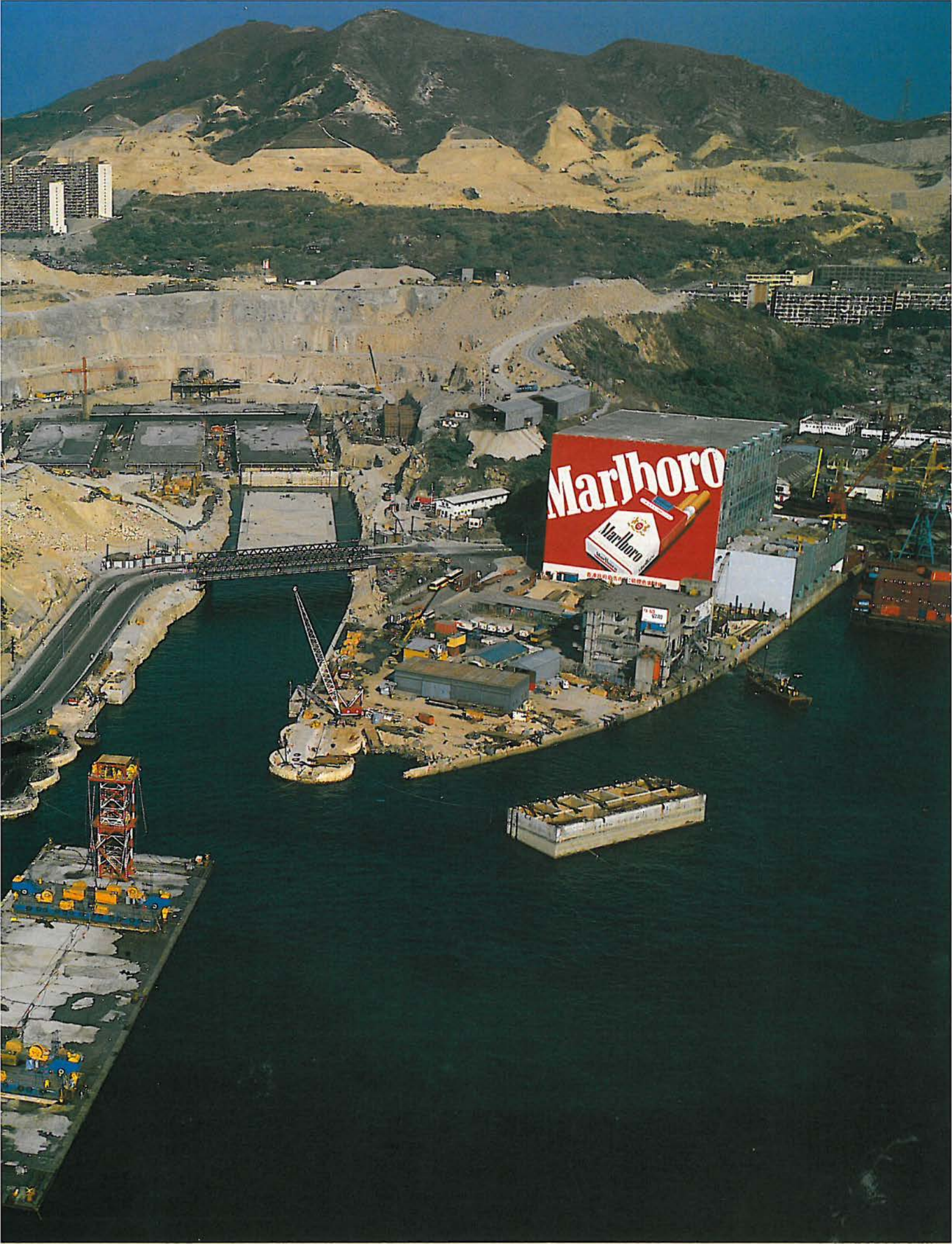
香港興建東區海底隧道，在茶果嶺進行挖掘工程。明年海底隧道交通量可增加一倍以上。
